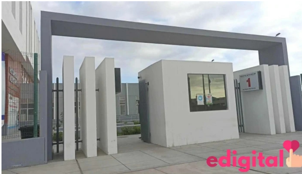
Gerencia regional red de salud islay edificio
